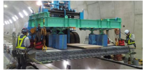
写真-1 プレキャスト PC 床版施工状況
