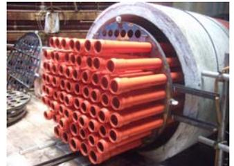
写真-1 プレファブレル配管工法
