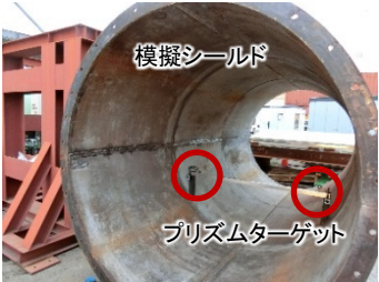
図-3 模擬シールドターゲット設置状況
