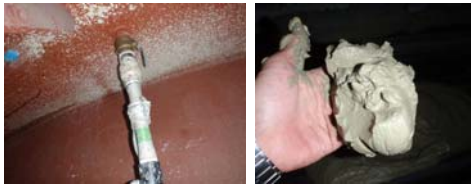
写真-2 可塑性充填材の注入状況
