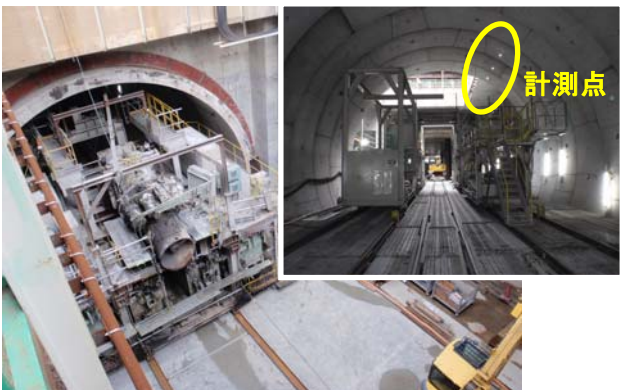
写真-5 二次解体・セグメントの計測状況
