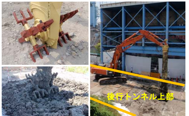
写真-4 中層混合攪拌による地盤改良状況
