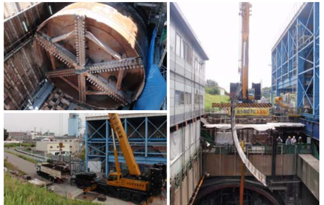
写真-3 シールドマシンの押出し・解体状況
