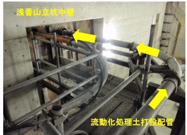
写真-3 打設配管のショートカット状況
