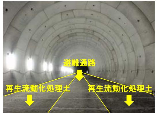
写真-1 流動化処理土の打設完了状況
