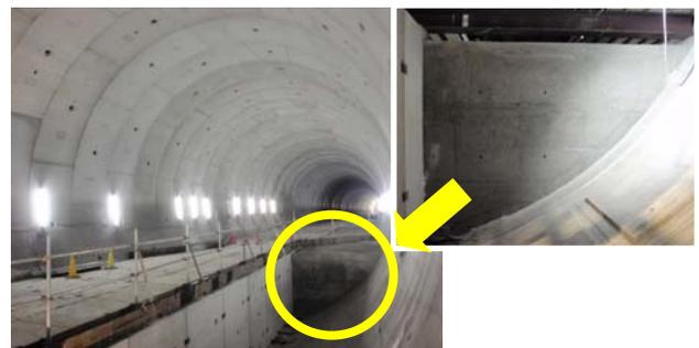
写真-4 シールド坑内の打設完了状況
