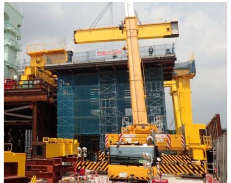
写真-4 門型クレーン組立状況
