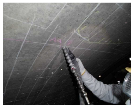
写真-1 削孔状況
