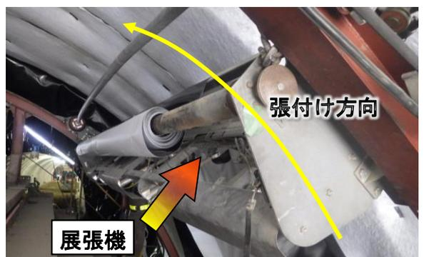
図3 展張機による防水シート施工状況
