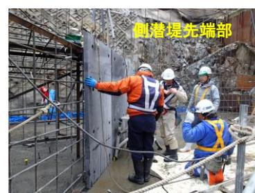
写真-5 UFCパネルの設置状況（近景）
