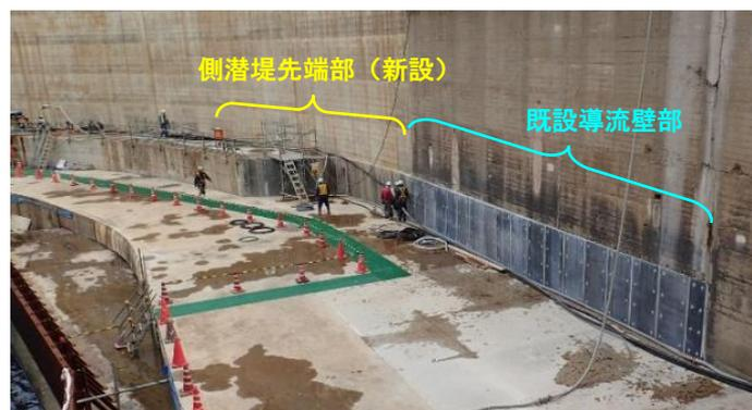
写真-4 UFCパネルの設置状況（全景）
