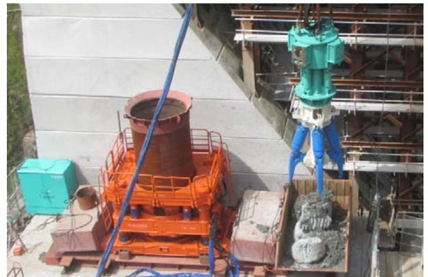
写真-4 A-CR 工法による堤体削孔
