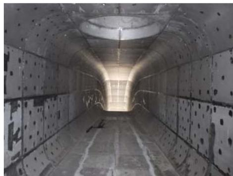
写真-2 放流管ライニングの完成状況
