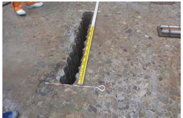
写真-3 補助孔削孔
