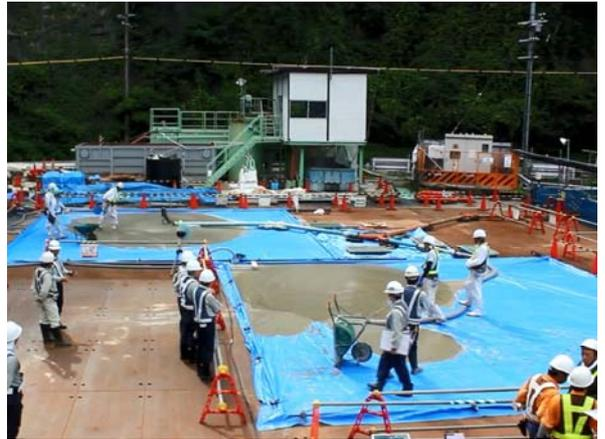
写真-1 水平圧送試験
