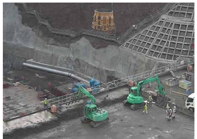
写真-6 ダム現場での施工状況
