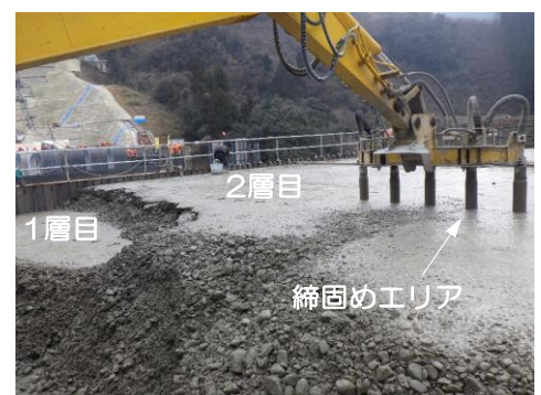
写真-3 2層打設状況
