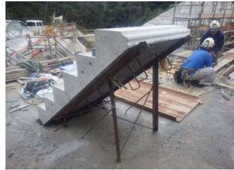
写真-2 据付状況 (階段部)
