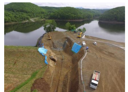
写真－4 新設堤体周辺状況
