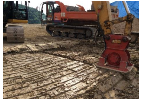
写真－1 油圧コンパクタ転圧状況
