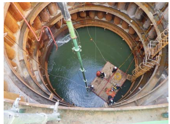
写真-3 底盤コンクリートの打込み
