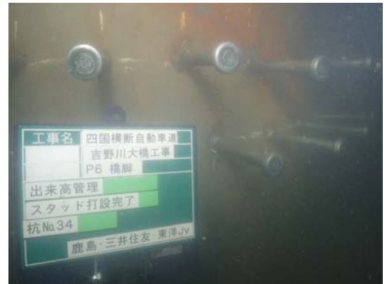
写真-1 水中スタッドの打設完了
