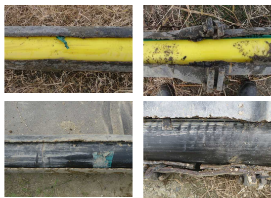
図5 施工後の PE 管状況
