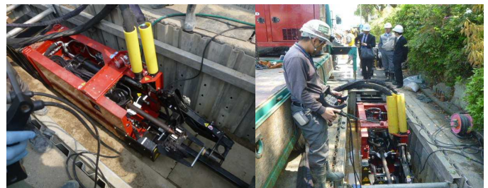
図2 施工装置の小型化及び地上からの操作
