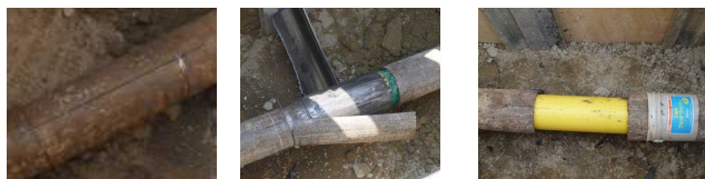
図4 ガス供給分岐管の切替施工状況
