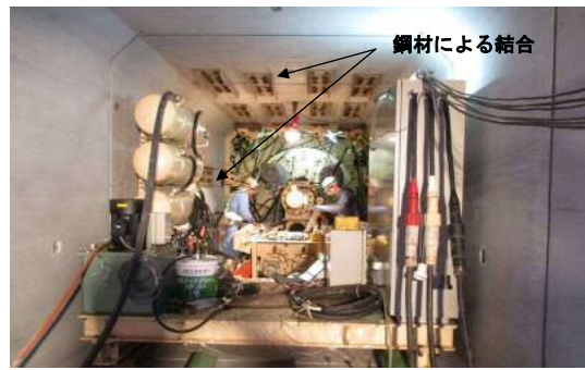
図4 自沈対策（函体結合状況）
