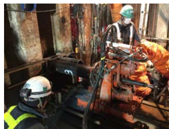
写真-1 パイプ工法施工
