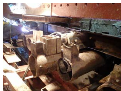
写真-3 パイプルーフ引抜状況
