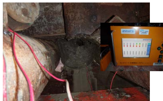
写真-4 パイプルーフ引抜部充填
