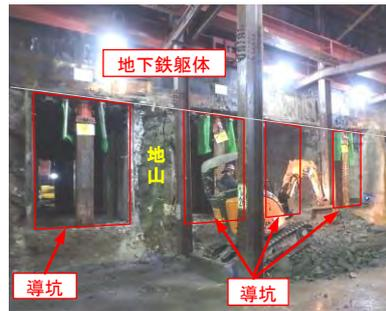
写真-1 導坑間掘削前の状況
