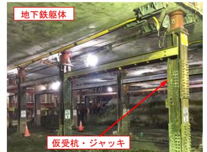
写真-2 導坑間掘削完了時の状況
