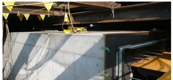
写真3 本打設脱型後の状況
