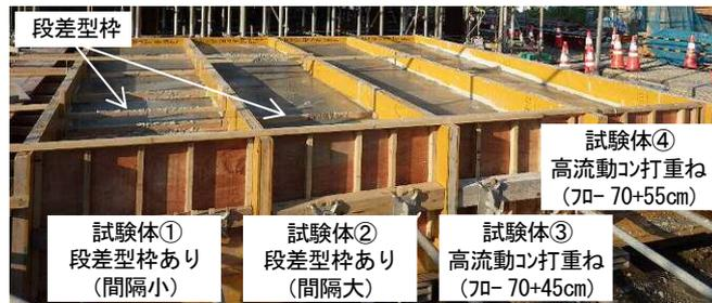
写真-1 事前試験①の試験体
