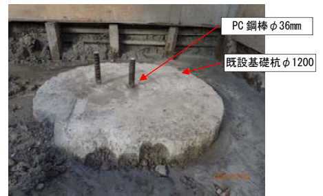
写真-2 既設基礎杭 PC 鋼棒設置
