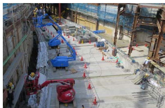
写真-6 PCa カルバート施工状況
