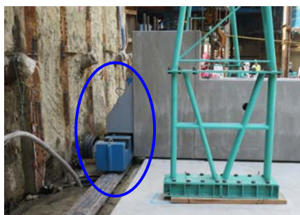
写真-4 レール台車(昇降ジャッキ付)
