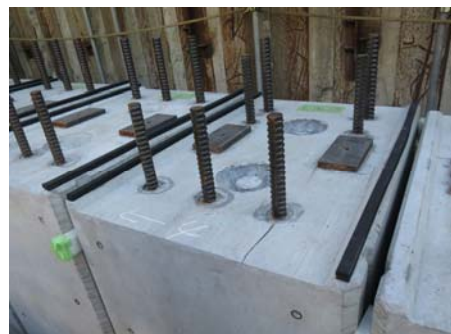
写真-2 接続部(モルタル充填継手)
