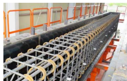
写真-1 頂版の配筋状況
