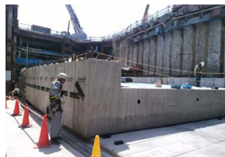
写真-5 底版の先行設置
