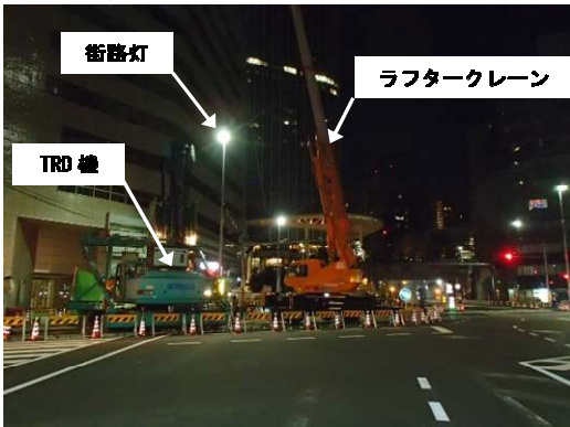
写真－1 施工状況
