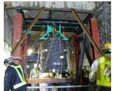
図-5 架台への固定状況
