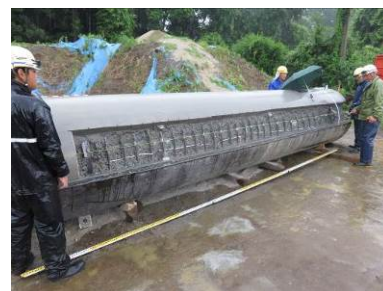
写真-5 鉄筋かごの変形の測定
