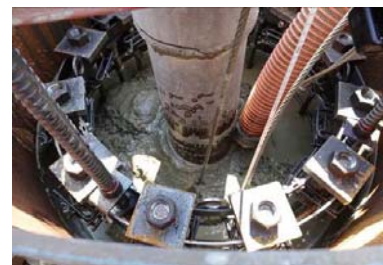
写真-3 バキューム処理
