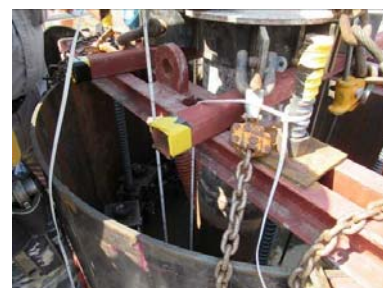
写真-4 鉄筋かご長の測定
