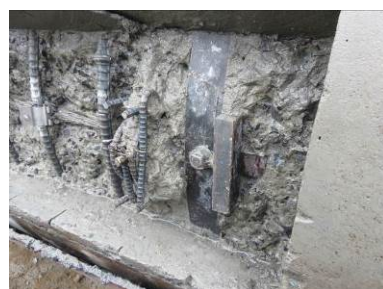
写真-6 杭頭部周囲
