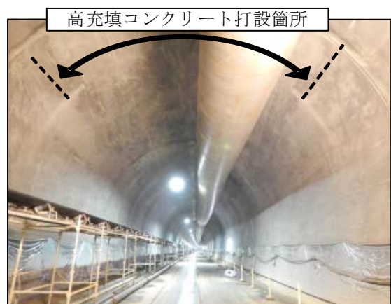
写真-1 高充填コンクリートの出来映え
