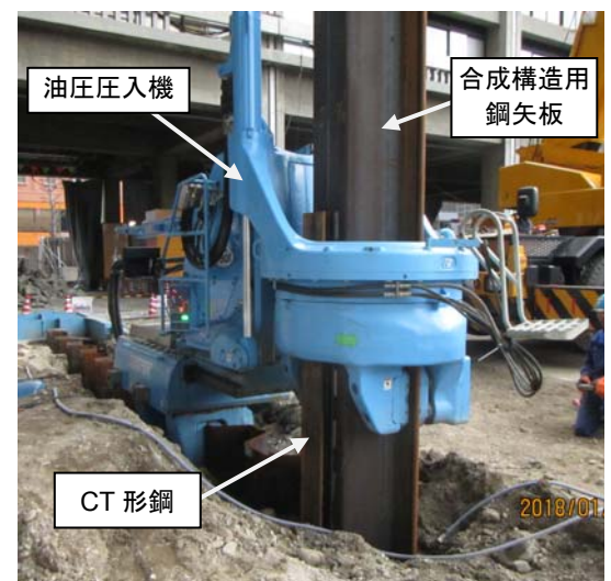
写真-1 合成構造用鋼矢板の圧入状況
