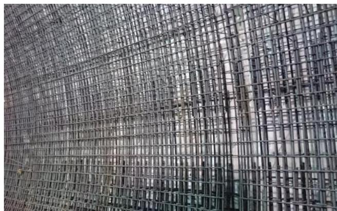
写真-1 坑口部における高密度配筋状況
