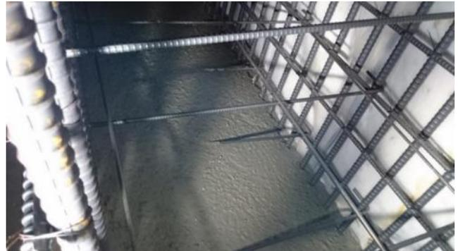
写真-3 コンクリートの流動状況
