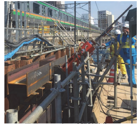
図-4 アンカー確認試験状況
