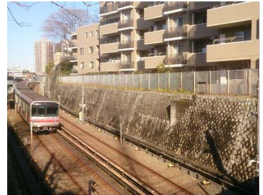
写真1 現場全景（非自立性地山箇所）
