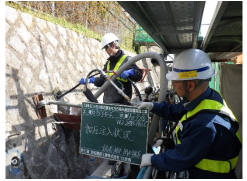
写真3 加圧注入状況
