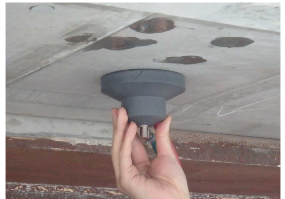
図 - 5 試験状況（近景）
