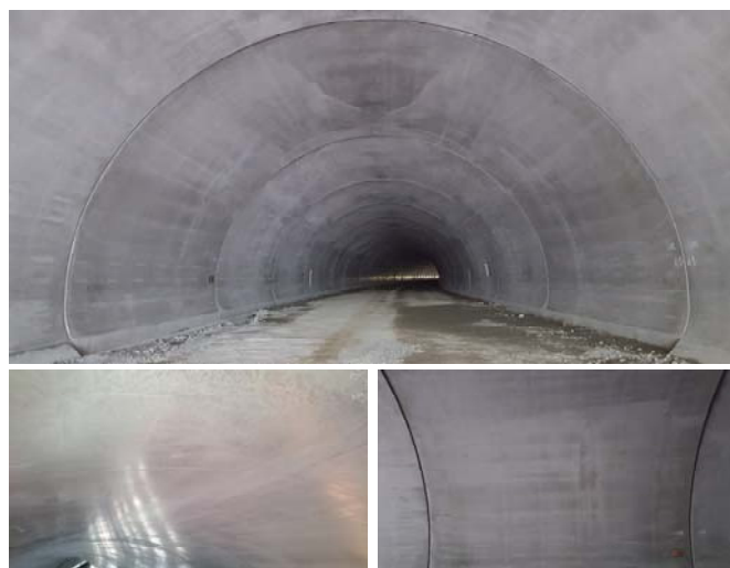
写真－２ 新規の高流動コンクリート仕上がり
