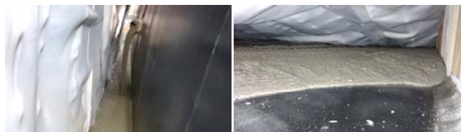
写真－１ コンクリート流動状況（側部・天端部）
