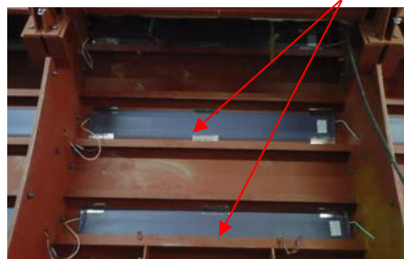
写真-1 面状発熱体シート設置状況
