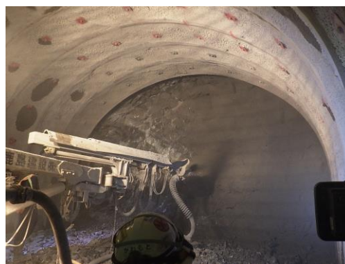
写真-2 吹付け状況
