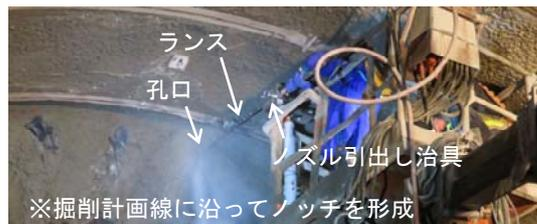
写真-3 WJによるノッチ形成作業の状況
