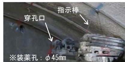
写真-1 穿孔状況 (外周孔装薬孔)
