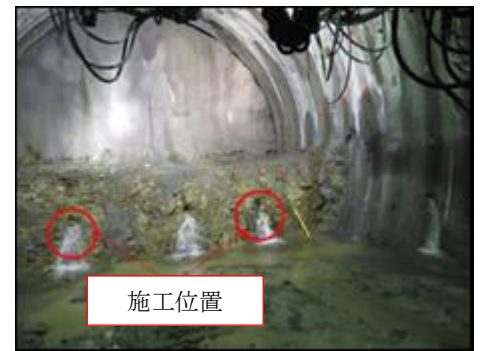
写真-2 短尺ボーリング施工位置
