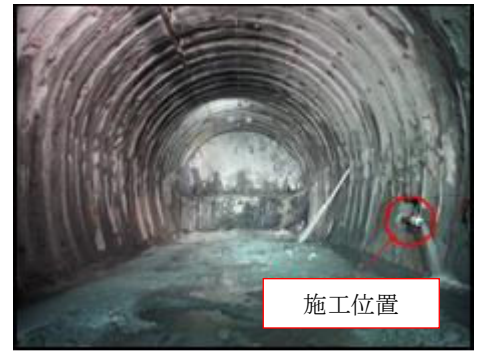
写真-1 中尺コアボーリング施工位置
