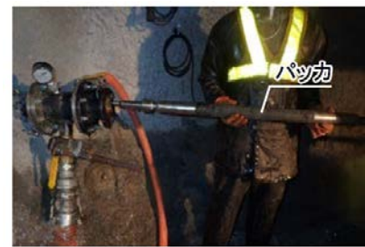
図-2 パッカ挿入状況
