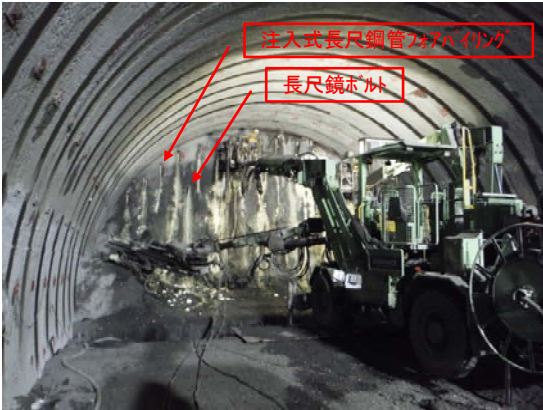
写真-1 長尺鋼管フォアパイリング施工状況
