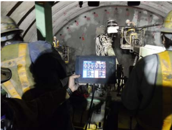
写真-2 切羽前方探査 実施状況
