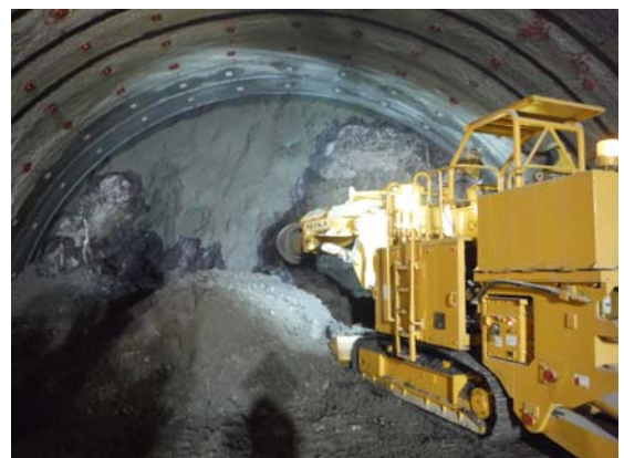
写真-3 掘削状況(DI-bパターン)
