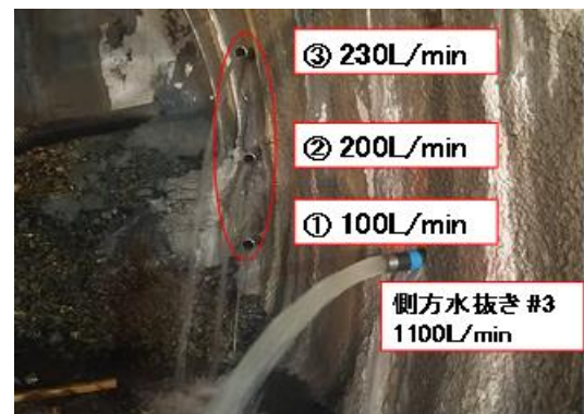
写真－2 前方水抜き (①～③)
