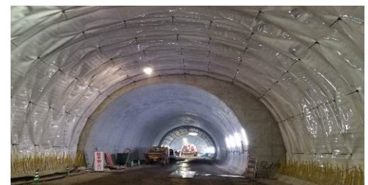
図-5 防水シート・吊金具設置状況
