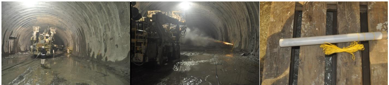
図1 発振孔削孔の状況
