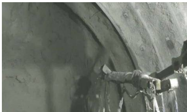
写真-1 吹付け作業状況
