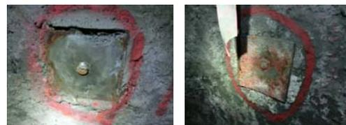
写真-2 左:ロックボルトの破断 右:プレートの湾曲
