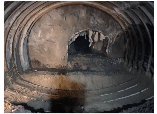
写真-1 全断面早期閉合施工状況 (Ls=6m)
