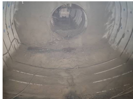
写真-1 全断面早期閉合施工状況 (Lf=6m)
