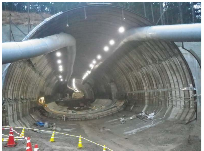
写真-2 インバート施工状況
