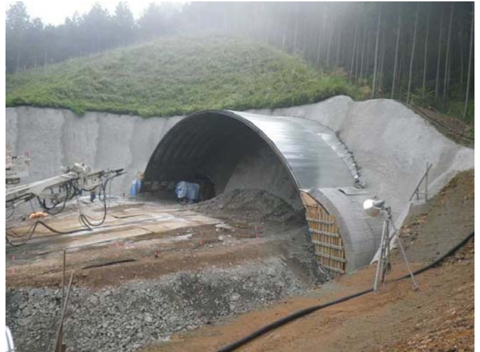
写真-1 上半掘削状況
