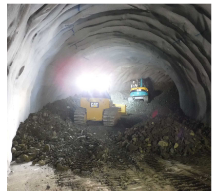
写真-3 埋戻し工施工状況
