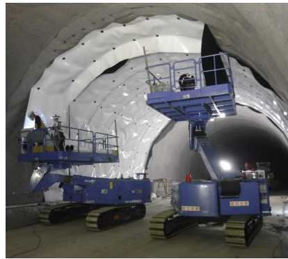
写真-2 遮水工施工状況
