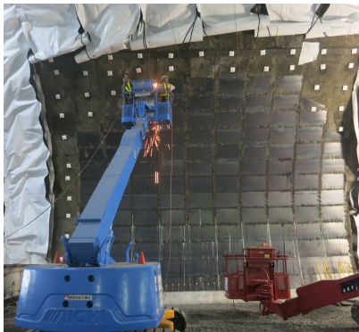
写真-1 閉塞工施工状況
