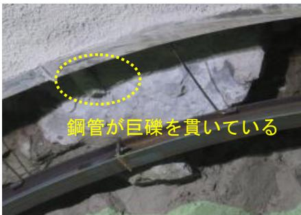
写真3 トンネル断面内に出現した巨礫 写真4 支保工上部に出現した巨礫
